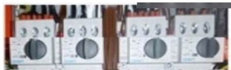
Рис. 1: Защитный выключатель электродвигателя
